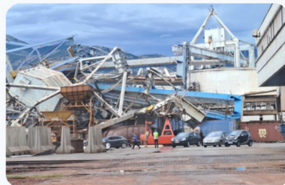
Srušeni pretovarni mostovi u Luci Bar
